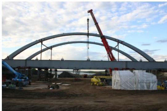
Bild 1: 2005 Errichtung der Autobahnbrücke BAB 38 über den künftigen Gewässerverbund, Bildautor B.-St.Tienz
