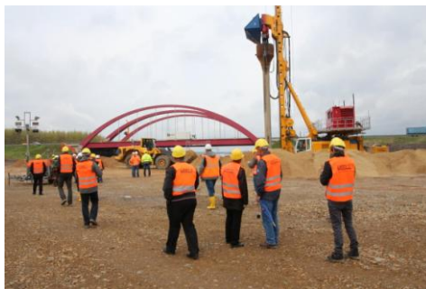
Bild 2: 2015 Baustellenbefahrung der Rütteldrückverdichtung im Zuge der Baugrundvergütung der Gewässerverbundtrasse).
