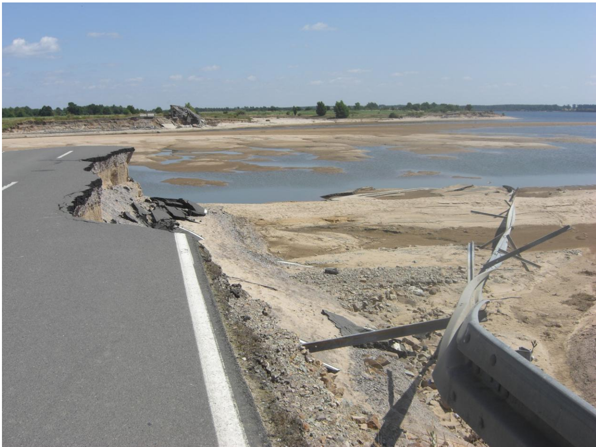
Foto: An der Durchbruchstelle der Mulde in den Seelhausener See beim Hochwasser 2013 (Durchbruchkanal und weggespülte Verbindungsstraße Löbnitz – Pouch. Juli 2013)
