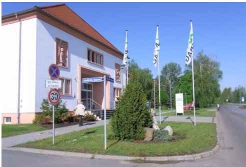
Verwaltungsgebäude der MIBRAG in Profen
