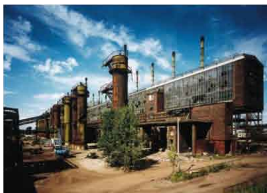
Abbruch der Schwelerei
